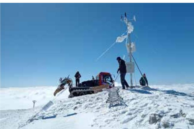
Il [video](#) a corredo di questo articolo mostra un intervento di manutenzione che prevedeva la **sostituzione del blocco sensore della stazione meteorologica installata a Capanna Margherita (la seconda più alta d'Europa)**. Le immagini sono spettacolari, ma va ricordato che viene affrontato in poco tempo un **dislivello operativo di circa 3500m**, per eseguire un intervento come questo sono necessari:
