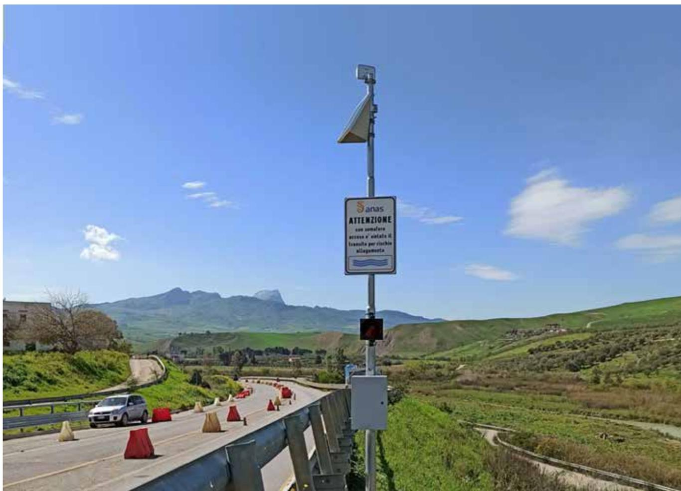
semaforiche poste a lato della carreggiata, uno per ogni senso di marcia sul viadotto. Inoltre, la stazione invia al centro di controllo un report di allertamento. I dati vengono costantemente inviati alla centrale di monitoraggio ANAS e, in caso di evento, un sistema
