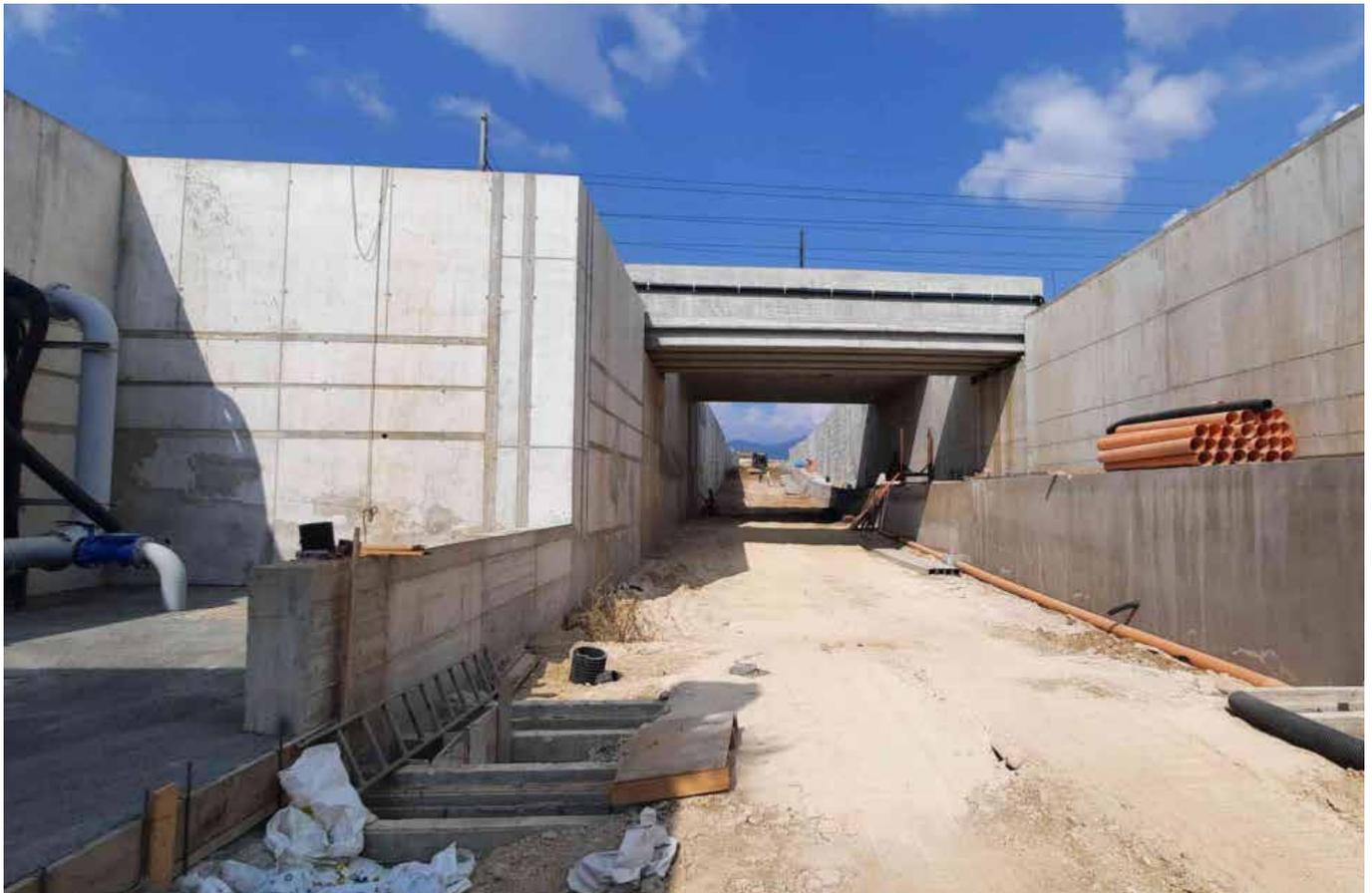
È in corso di installazione un **sistema di monitoraggio e allertamento** per un nuovo **sottopasso ferroviario** nel Comune di **Battipaglia**, utile ad **inibire la circolazione** in caso di **allagamento** dello stesso, situazione che si potrebbe verificare a fronte degli **eventi alluvionali estremi** che si verificano sempre più di frequente. CAE, per conto di GBL Costruzioni SUD srl, sta procedendo all'installazione del sistema che consiste in:
